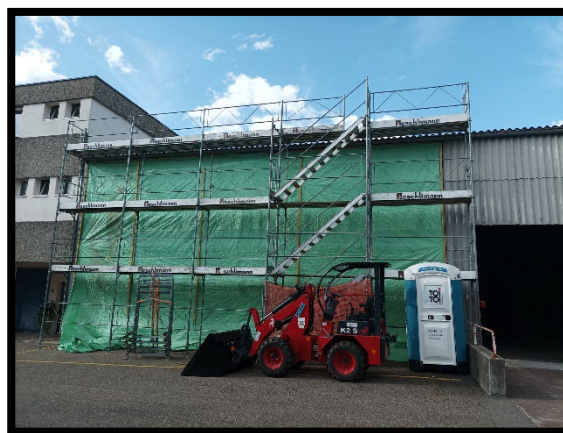
Abbildung 11- Umbau der Lagerhalle am Einschlagweg 37
